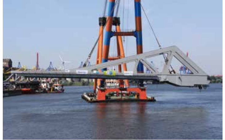
Schwimmkranmontage in Hamburg
