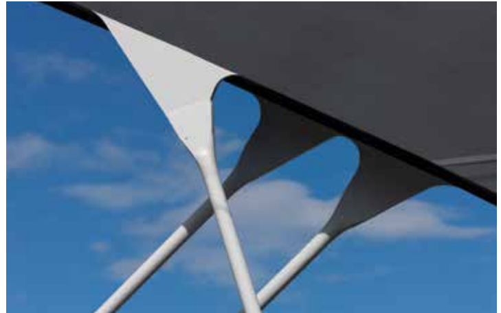
Stauchgeschmiedeter Hängeranschluss
